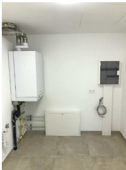
Photos : Aménagement type avec chaudière, armoire métallique pour collecteurs et coffret électrique (Photo d'illustration, non contractuel)
