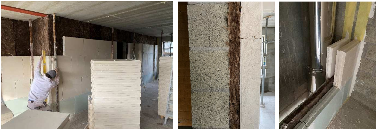
Photos : Réalisation soignée des cloisons, doublage acoustique d'un mur porteur et isolation acoustique d'une gaine technique avec une cloison doublée et isolée (réalisation ARCHIPLUS srl)
